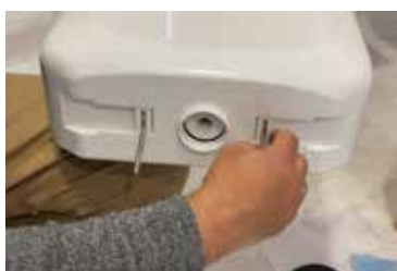
A aplicação do autoclismo permite facilmente a regulação de acordo com o tipo de sanita.
